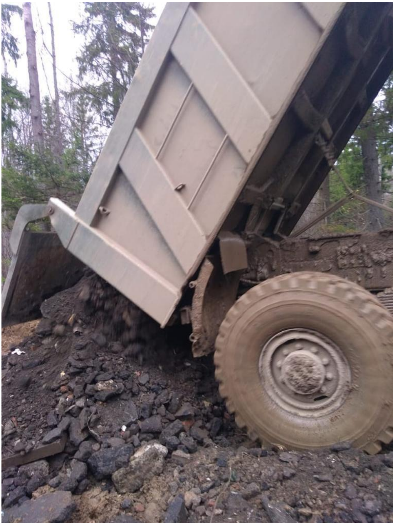
Отсыпка лесных дорог
