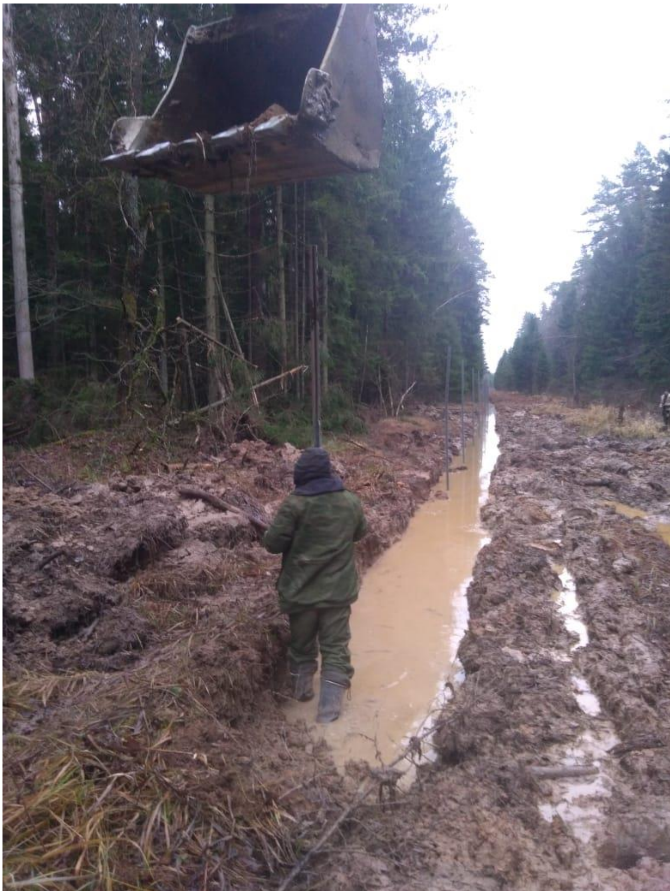
Установка опорных и промежуточных столбов
