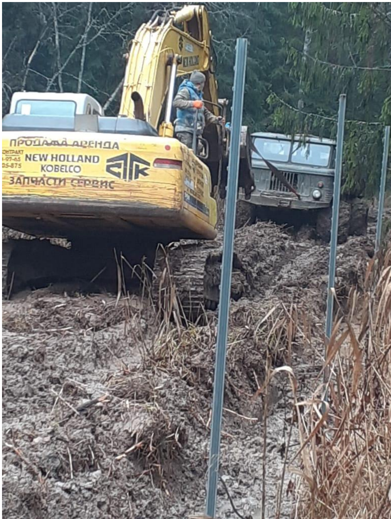
Установка опорных и промежуточных столбов
