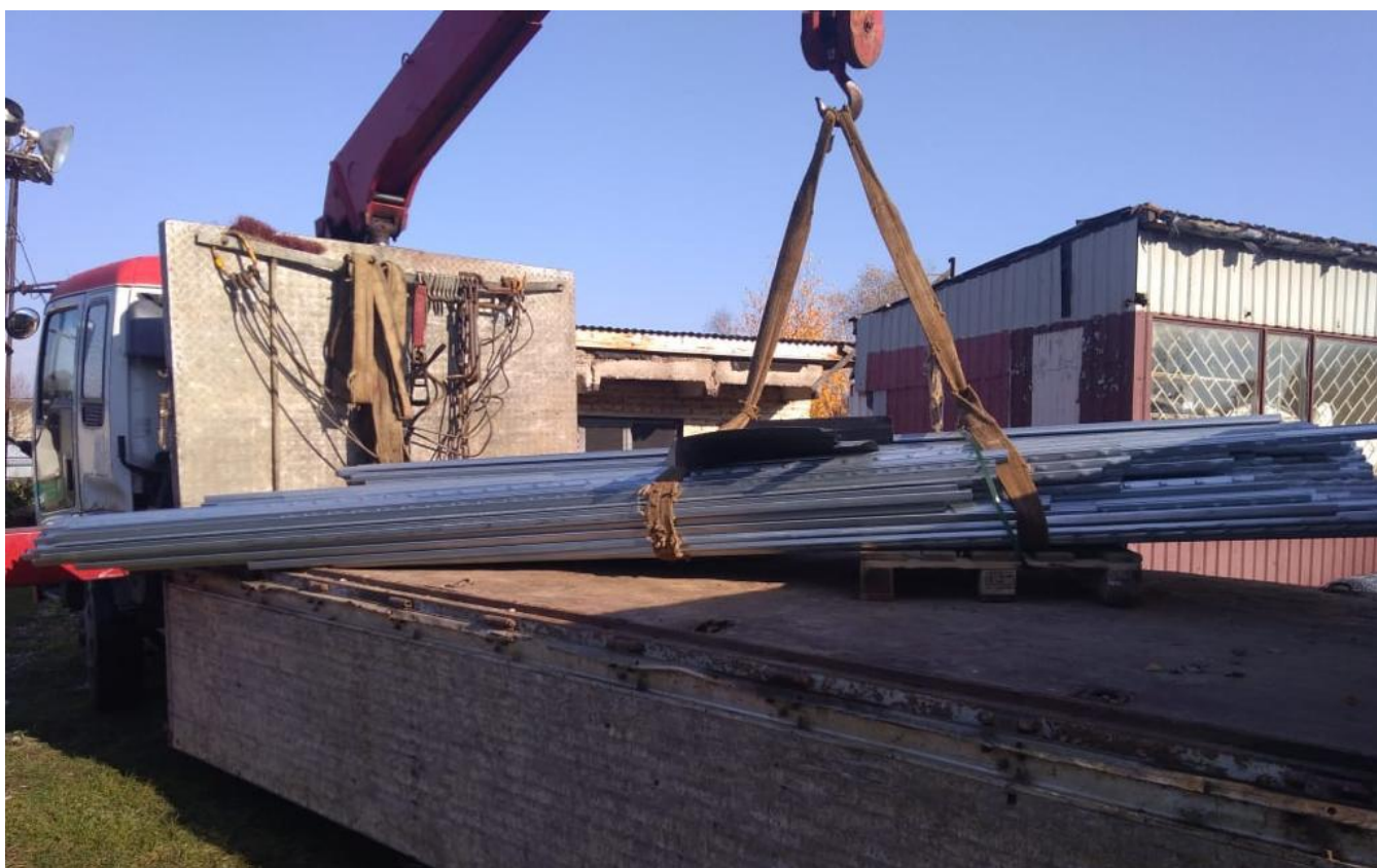
Доставка промежуточных стоек для монтажа ограждения
