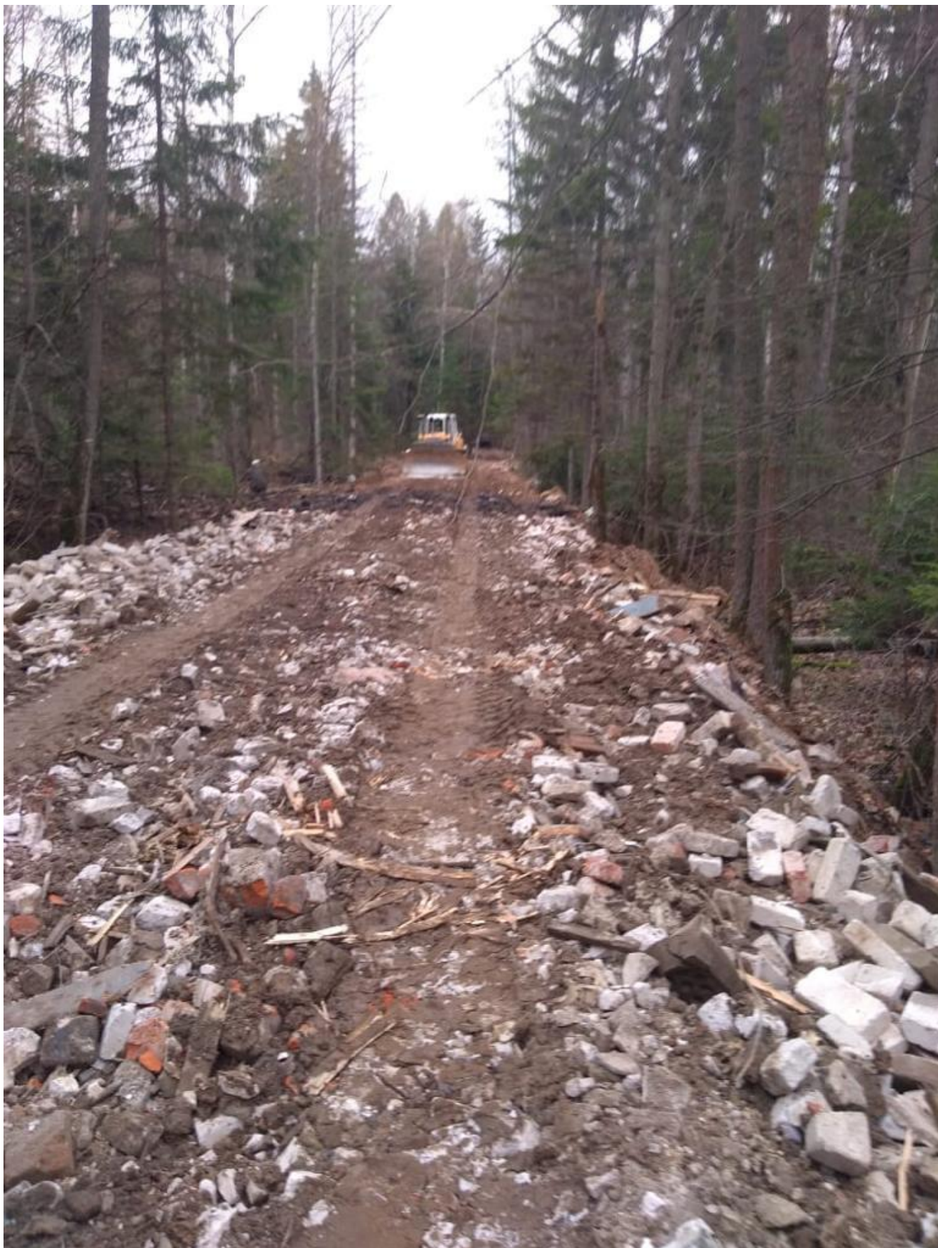
Устройство дорог (после отсыпки)
